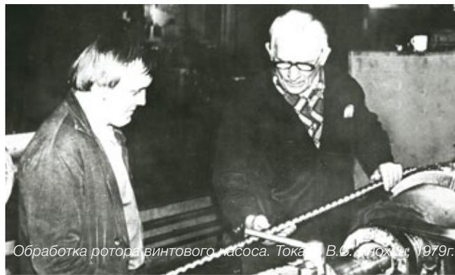
Обработка ротора винтового насоса. Токарь В.С. Анохин, 1979г.
